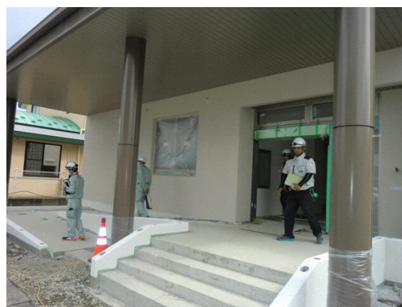
玄関ポーチ・スロープ
