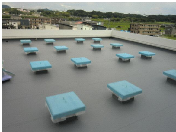
屋上シート防水 太陽光パネル基礎
