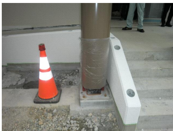
アプローチ屋根支持柱 柱脚
