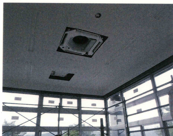
内部 公民館棟 2階会議室 現況
