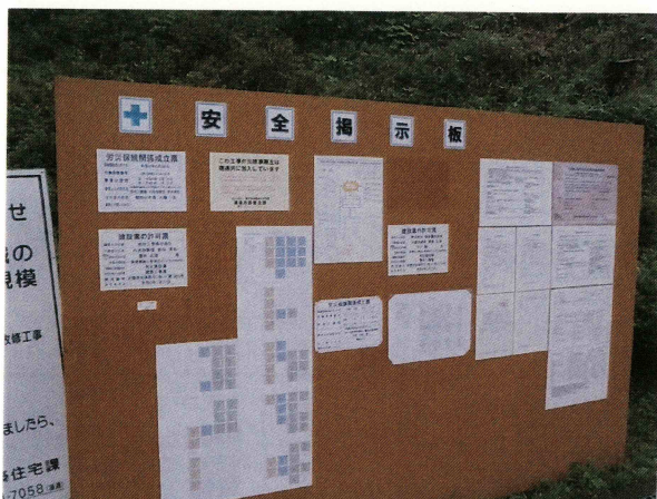
掲示物 建設業許可標識、労災保険関係成票、 建退共制度の適用標識、施工体系図
