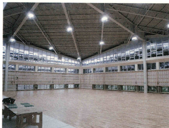
内部 体育館棟 1階 現況
