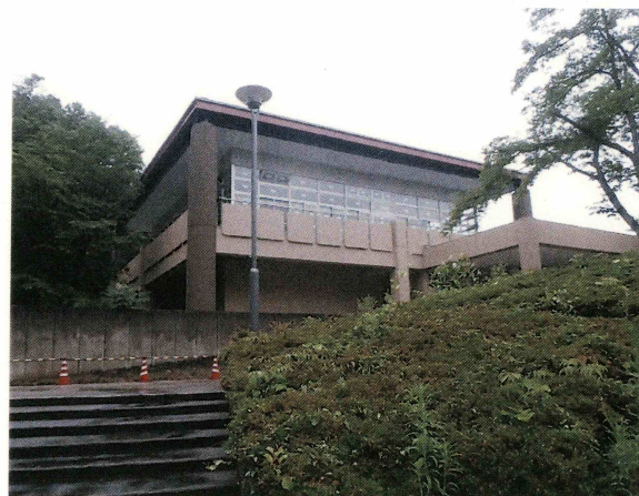
外部 公民館棟 南東面 現況
