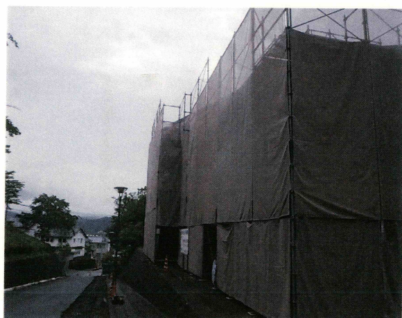
外部 体育館棟 西面 現況
