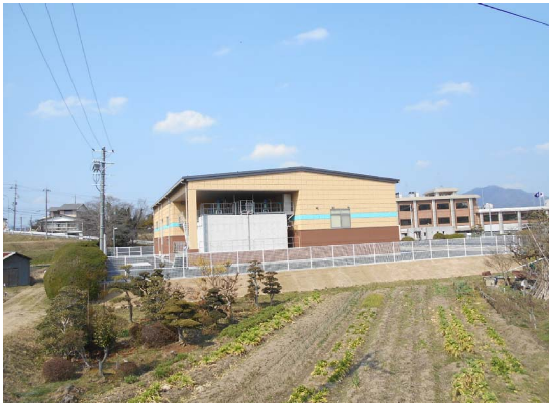
上下水道部庁舎・堀浄水場
