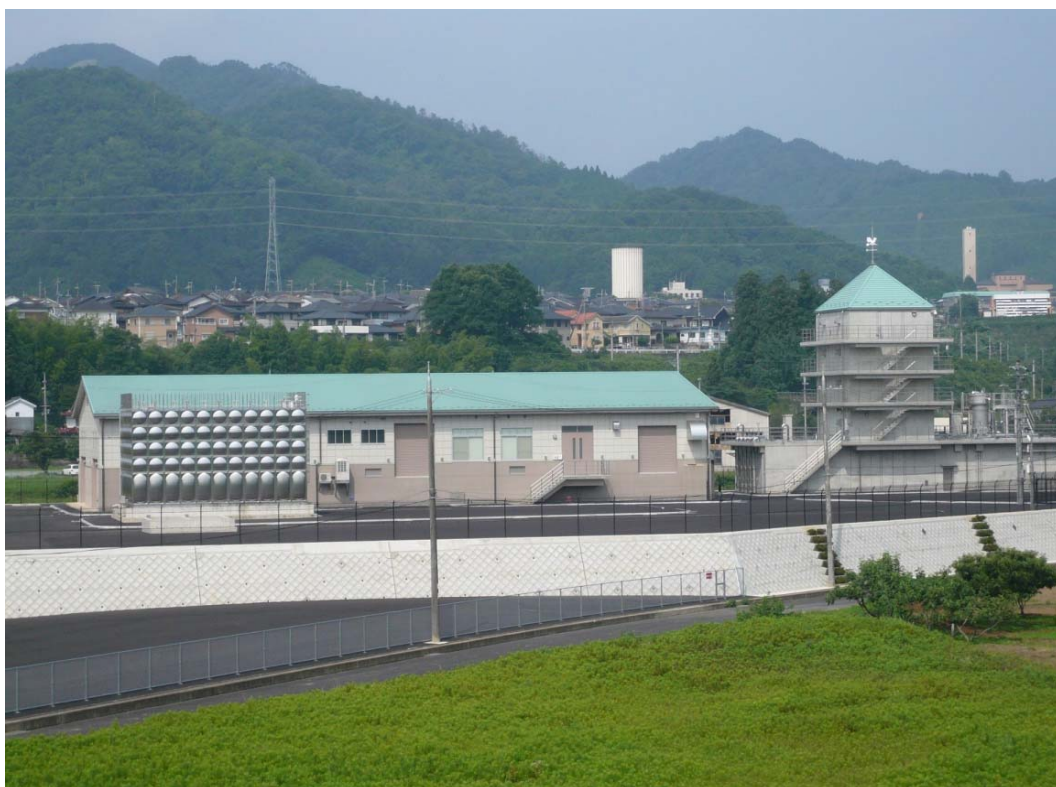
下荒河浄水場
