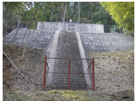
上町第2配水池
