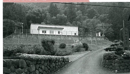
額田簡易水道 今西中浄水場
