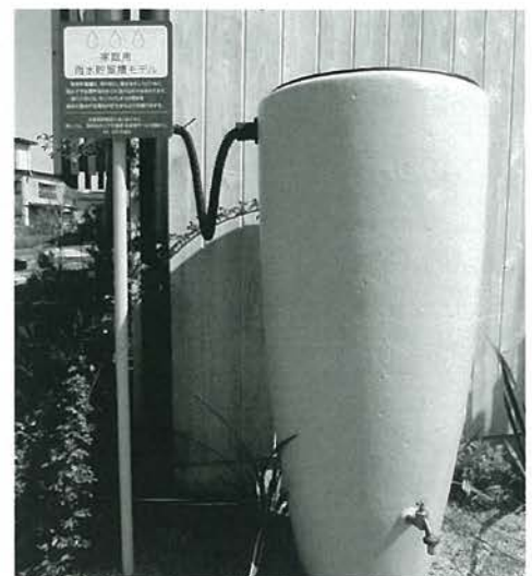
ゆらのガーデン内に設置した雨水貯留槽
