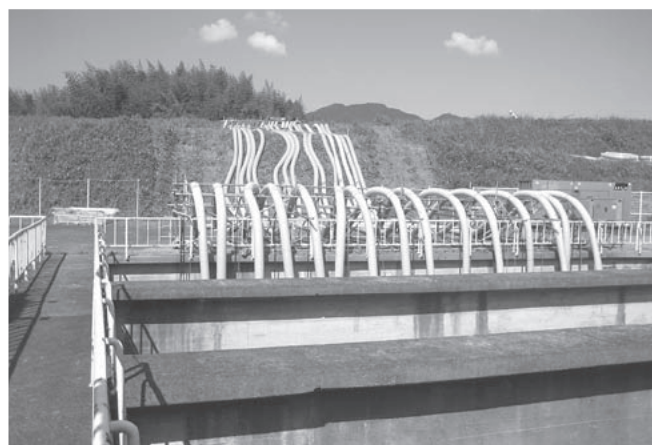
和久市ポンプ場の復旧状況 15台の仮設ポンプで大雨に備えています
