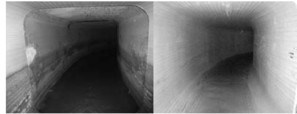
管更生による長寿命化工事(左:更生前 右:更生後)
