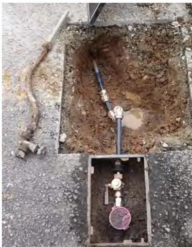
写真 4.1.3 鉛給水管の更新
