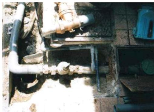
(鉛製給水管取替え工事風景)
