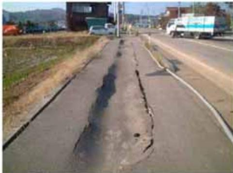
写真-1 路面陥没状況 (小千谷市内)
