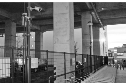
駅周辺に設置の防犯カメラ
