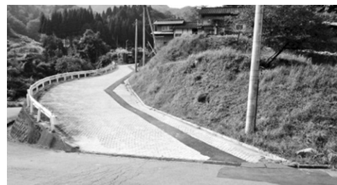
水道管の布設が進む橋谷地区
