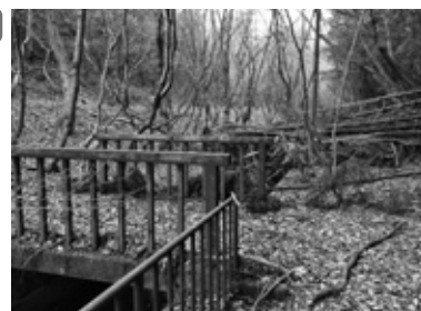
都市公園の荒廃状況
