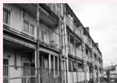
解体予定の小谷ヶ丘団地
