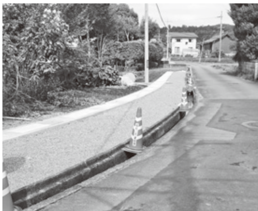
数年間工事中が続く市道拡幅工事
