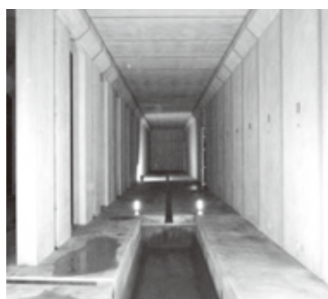
土師新町貯留施設
