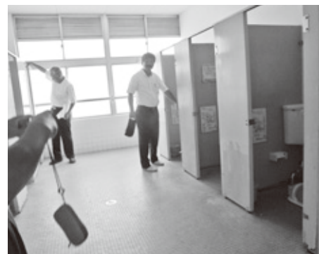
雀部小トイレの現地確認
