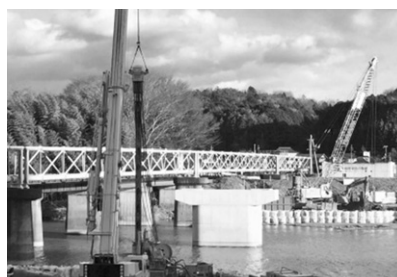
2橋脚の工事が同時に進む高畑工区
