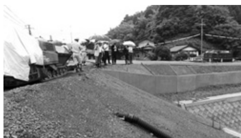
宮の奥川堤防工事現場(北有路)
