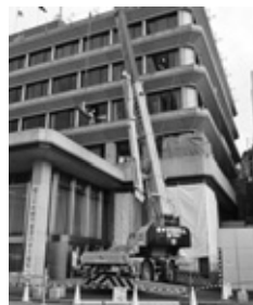
耐震工事がすすむ市庁舎
