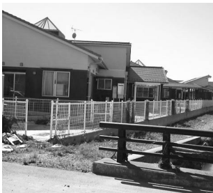
水害で被災した社会福祉施設
