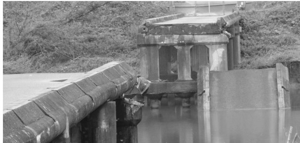
中央部65mが流された有路下橋
