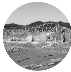
ハウス崩壊状況(石原地内)
