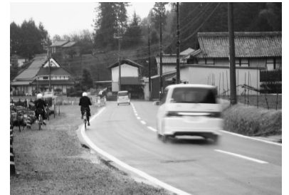
水溜りがなくなり路面舗装をまつ歩道
