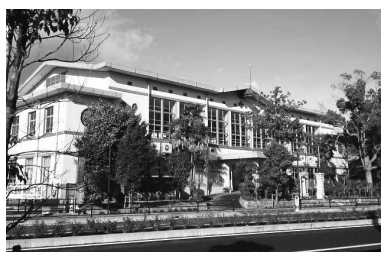
昭和12年に建てられた惇明小学校管理棟
