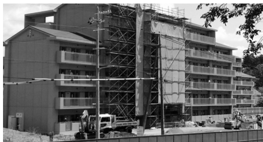
インフレスライド条項が適用される市営住宅南天田団地第2期棟建替工事
