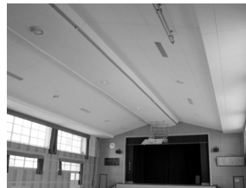
早期改修が求められるつり天井
