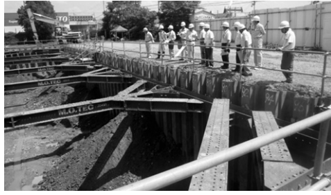
雨水貯留施設工事(堀高田公園)
