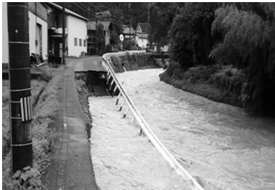
口榎原地内河川災害
