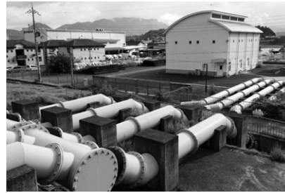
弘法川救急排水ポンプ設備
