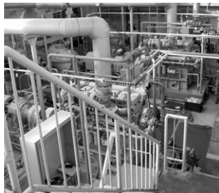
水没対策が求められる和久市ポンプ場
