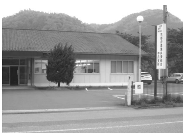
綾部市西原町の支所事務所
