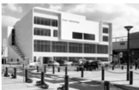
(仮称)市民交流プラザふくちやまの外観
