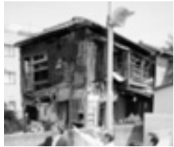
放置された空き家
