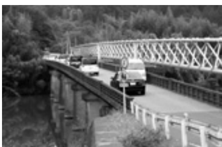
都市計画道路 多保市正明寺線の高畑橋
