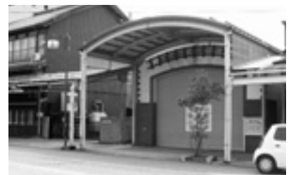
アーケード撤去のポッポランド2号館
