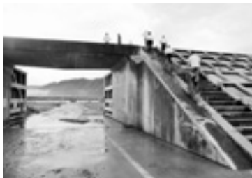
津波に飲み込まれ荒れ果てた宮古市田老町の堤防
