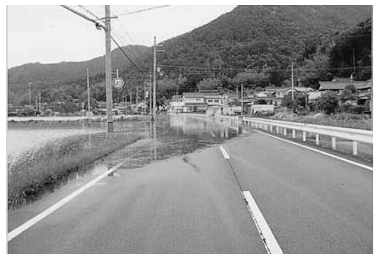
府道綾部福知山線が池部地内で冠水 2011 5 30
