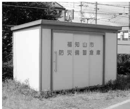
各地区に設置されている防災備蓄倉庫
