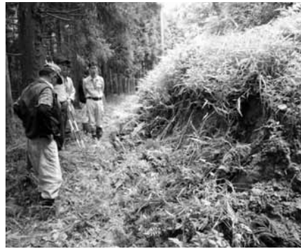
台風2号による土砂崩れの現場(大内山田)
