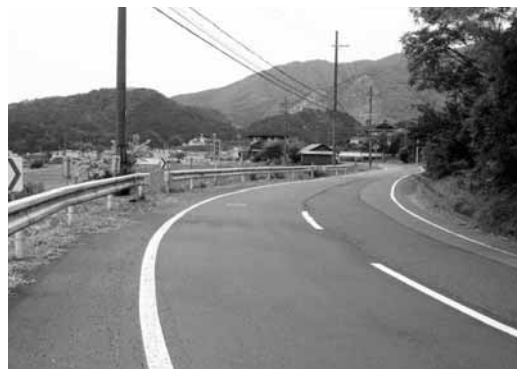
道路が狭くなった箇所(山崎地内)
