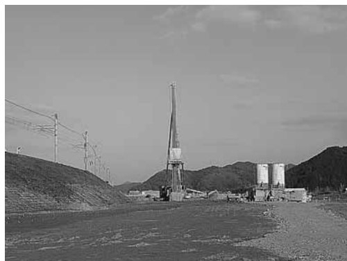
公庄地区の築堤工事現場
