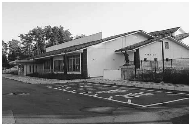
完成した武道館
