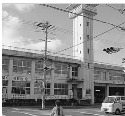
老朽化が進む現消防署
