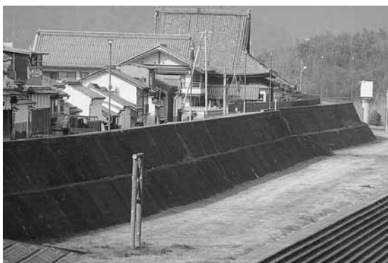
築堤後80年以上が経過した福知山大堤防
