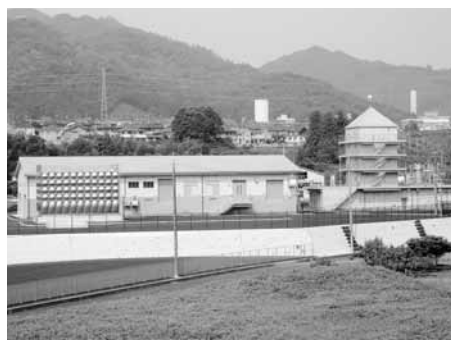
下荒河浄水場
