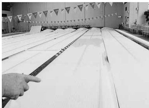
夜間に水温が下がらないよう、シートが張られている
