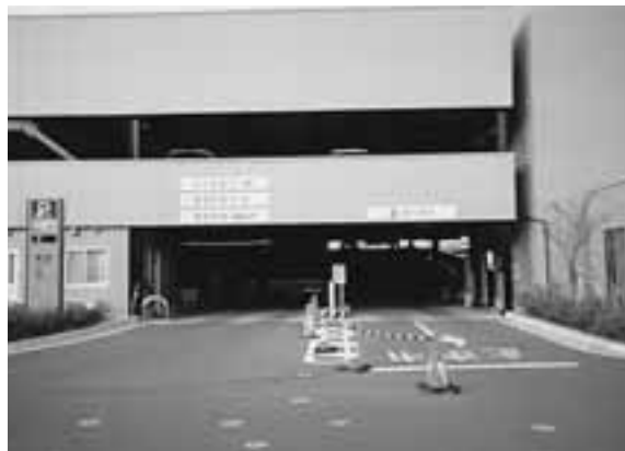
交差し危険な市民病院駐車場
