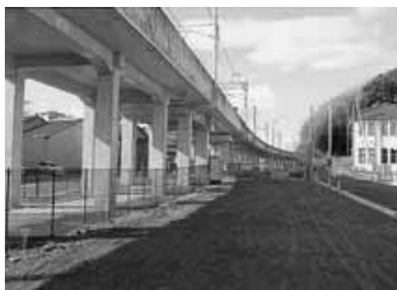
地域振興のため、有効活用が望まれる高架下・軌道跡
