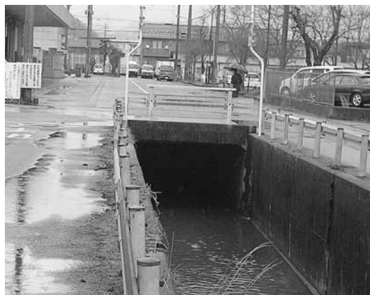
公設卸売市場内の水路部分
