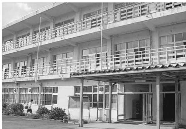
早急なる耐震改修が求められる学校施設
