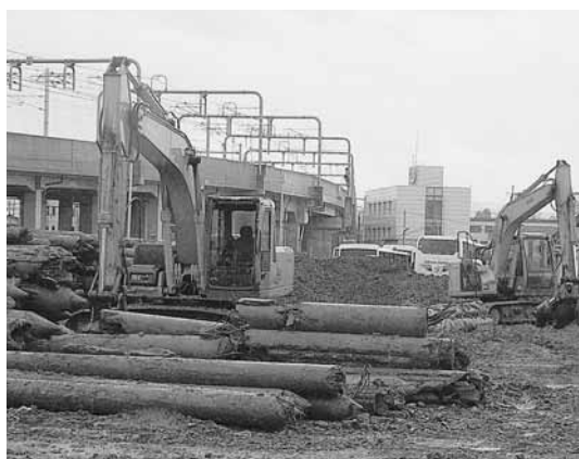
旧ガス基地跡地の残存杭撤去
