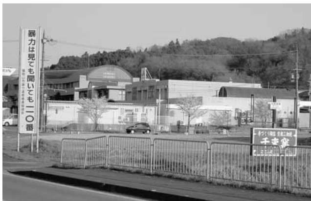
当初の新学校給食センター建設予定地
