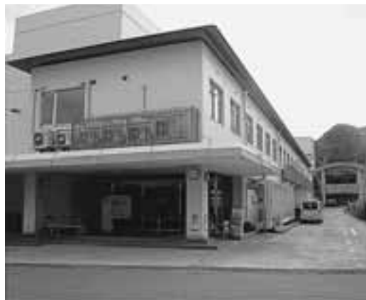
耐震改修が待たれる新大江病院
