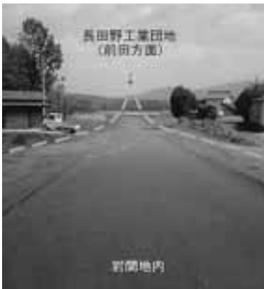
前田岩間線の未整備区間
