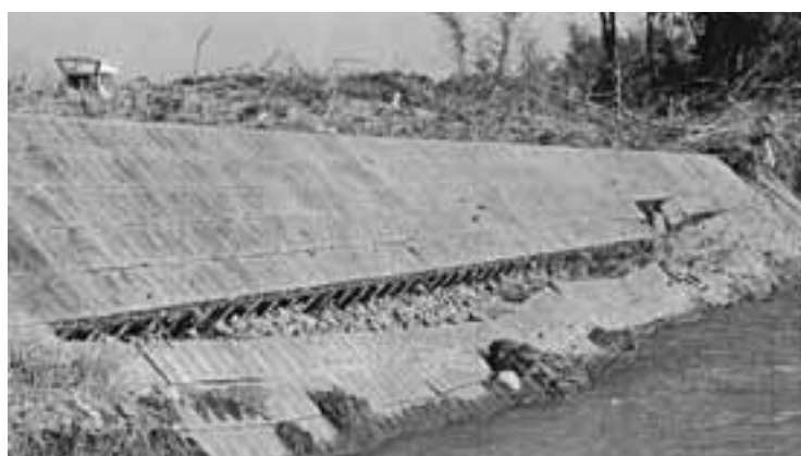
台風23号で決壊寸前になった土師川左岸堤防(福知山市水内)
