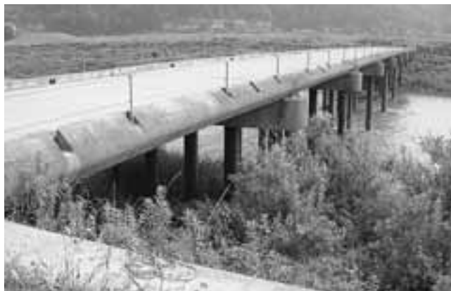
抜水橋化が待たれる波美橋
