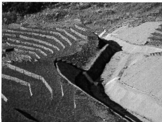
「堆積工・導流堤」
