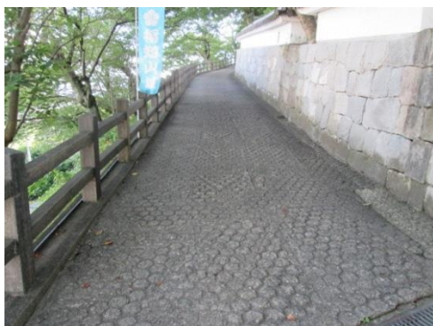
(園路舗装改修)
