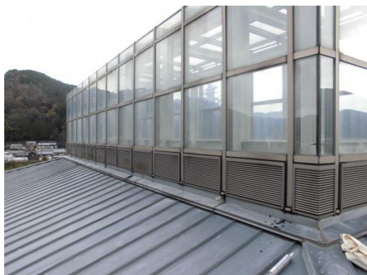
ホール屋根トップライト部
