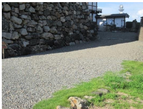
(城周囲の砂利舗装新設)
