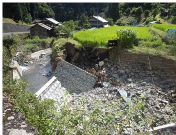
普通河川北原川（大江町北原地内）
