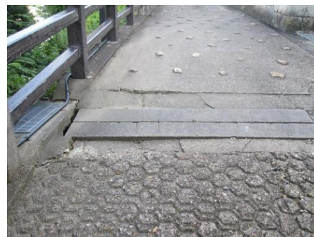
(園路横断水路の改修)
