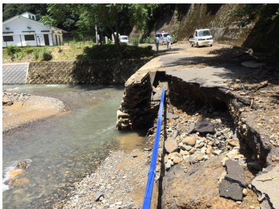
市道下天津長尾線（一尾地内）
