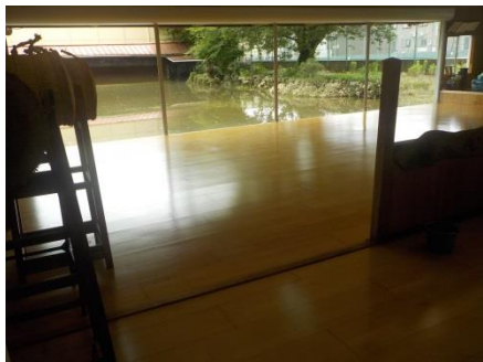
弓道場浸水状況
