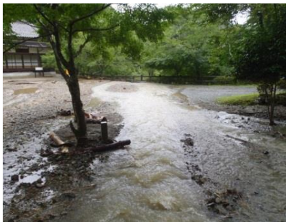
【被災状況】長安寺公園水路の横断暗渠が詰まり公園内に土砂流入、法面崩壊
