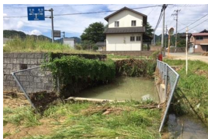
防火水槽フェンス破損・積泥 (牧)
