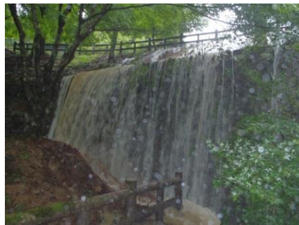
【被災状況】長安寺公園水路の横断暗渠が詰まり公園内に土砂流入、法面崩壊
