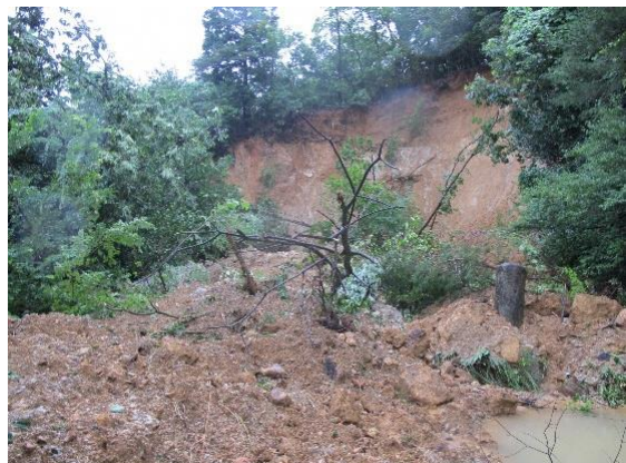
法面から崩落した土砂
