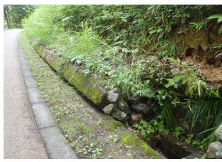
【被災状況】左：平和公園排水不良により溢水 右：三段池公園石積転倒
