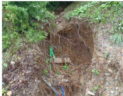
【被災状況】長安寺公園水路の横断暗渠が詰まり公園内に土砂流入、法面崩壊
