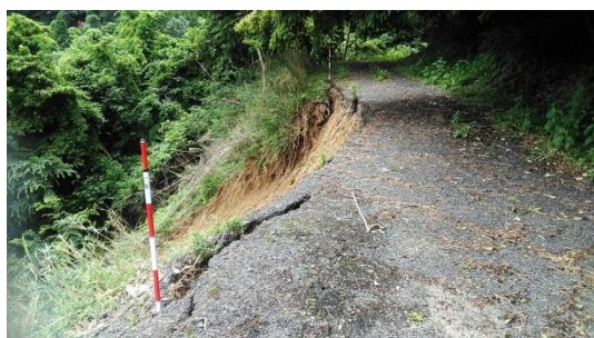
管理道路損壊
