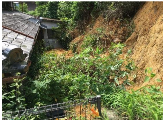
グラウンド法面の崩落した土砂
