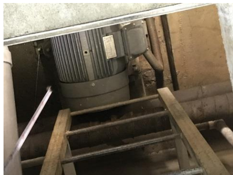
温水プール地下ポンプ等施設
