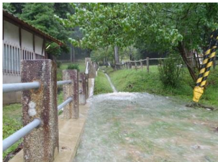
【被災状況】左：平和公園排水不良により溢水 右：三段池公園石積転倒
