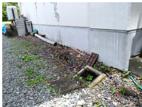
建物周辺地割れ状況
