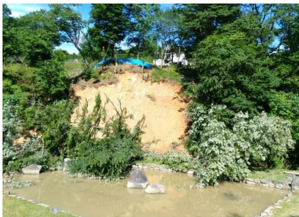
法面崩落状況
