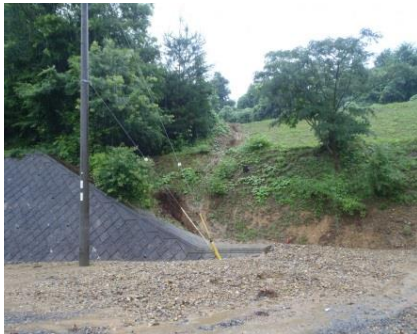
【被災状況】工業団地緩衝緑地の法面崩壊、土砂流出
