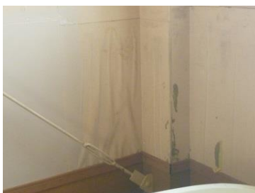
浸水による内壁破損 (庵我分団第2部)
