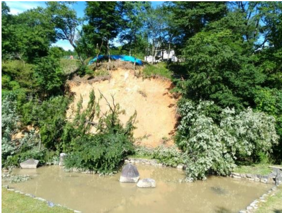
法面崩落状況
