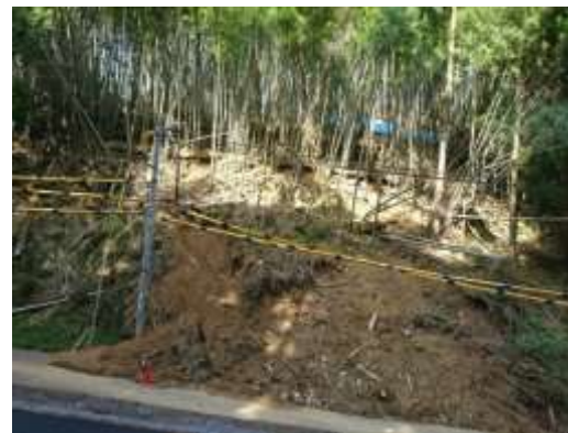
地すべり下部 (市道小谷線)
