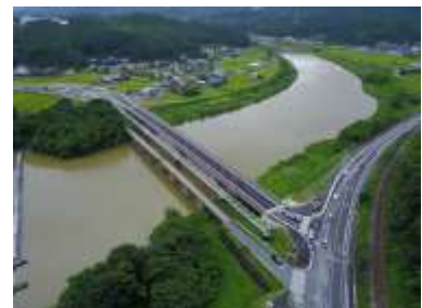
※H29.8 高畑橋水内側上空から
