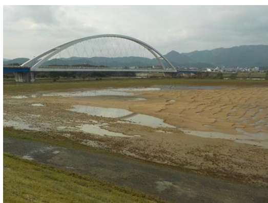
猪崎河川敷運動広場グラウンドの状況
