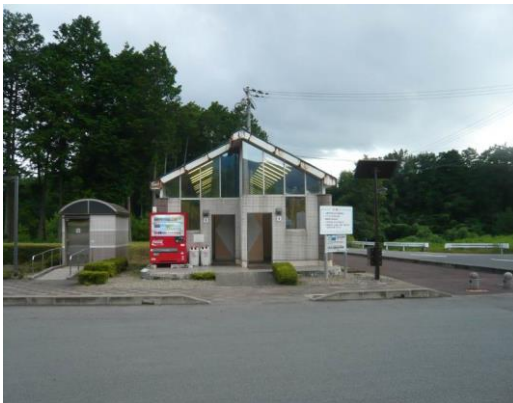
第2駐車場 外観
