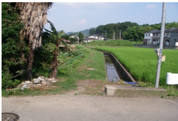
土19号線の現況
