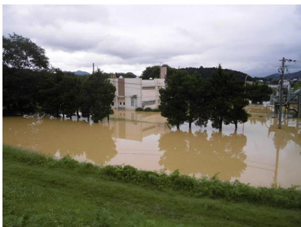
段畑污水中継ポンプ場 浸水状況 (土師地内、8月17日 12時57分撮影)
