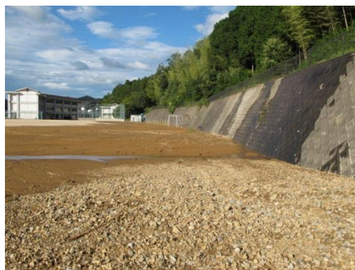
遷喬小学校グラウンド(石原)に流入・堆積した土砂と汚泥の状況。 H26. 8. 18撮影
