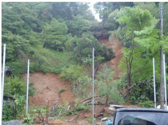
三段池公園（城山地内）被災状況
