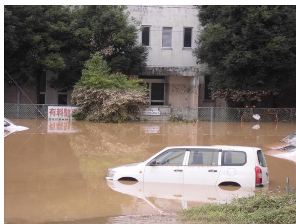
蛇ヶ端污水中継ポンプ場 浸水状況 (蛇ヶ端地内、8月17日 11時27分撮影)
