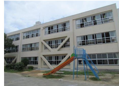
小学校・中学校施設空調設備設置事業
