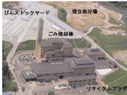
ごみ焼却施設基幹的設備改良事業
