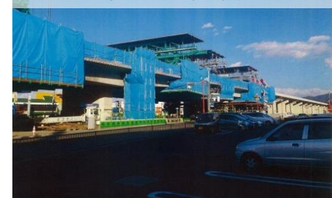
国道9号福知山道路（長田野～岡）完成記念イベント事業 (H25.12月 工事が進む現場の様様)
