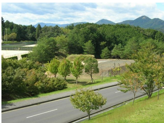
テニスコート増設箇所全景
