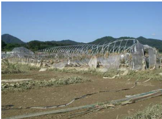
ハウス崩壊状況（石原地内）
