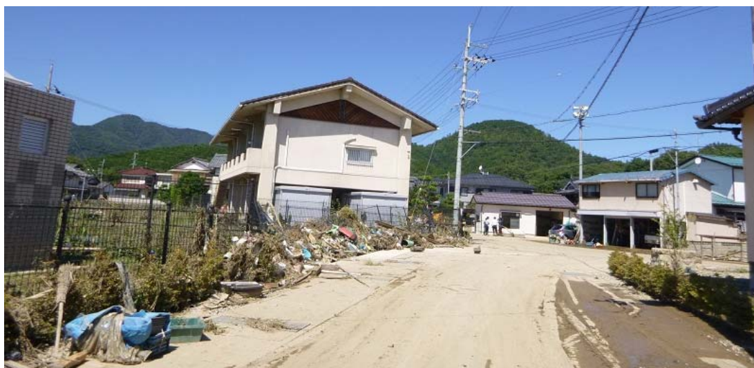
戸田地区 調整池フェンスの被災状況
