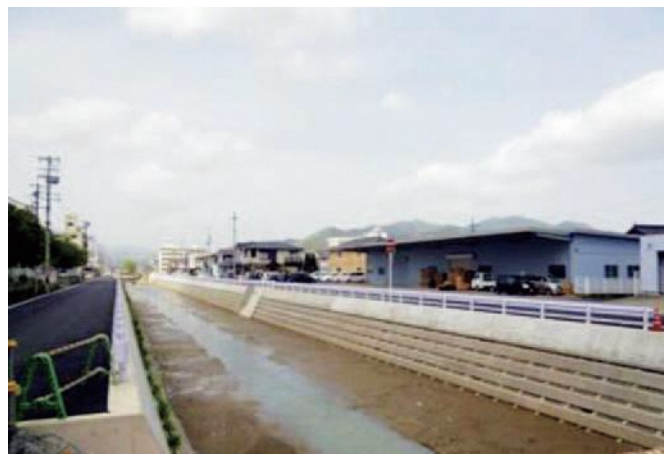
⑤ 弘法川の河川改修
