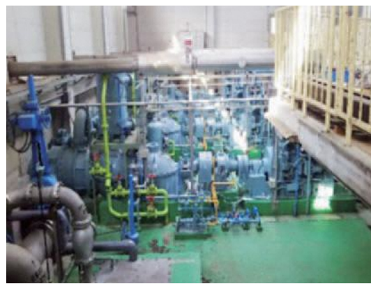
③ 和久市ポンプ場
