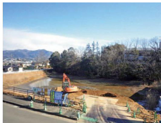
② 桃池調整池（工事中）
