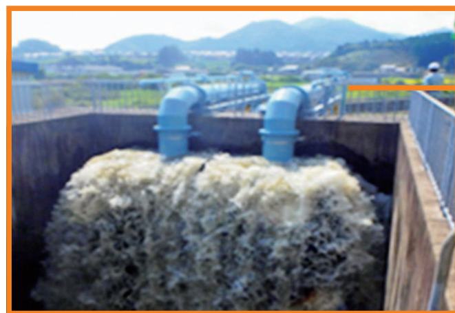
④ 荒河排水ポンプ試運転の様子
