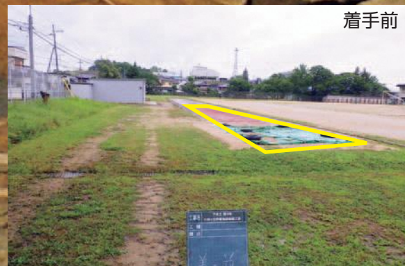
小谷ヶ丘貯留施設（桃映中学校グラウンド内埋設状況）
