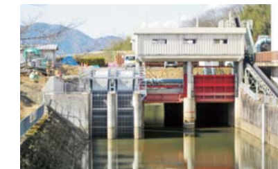
法川排水機場
