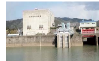
荒河排水機場
