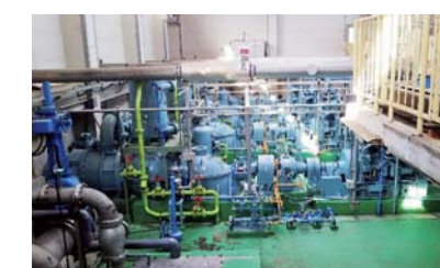
和久市ポンプ場
