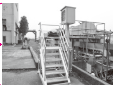
荒河排水機場(国) (操作盤他高所化)
