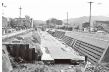
河川改修工事の状況 (弘法川：弘法川橋より上流付近)
