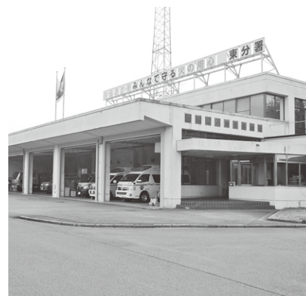
土のう保管庫を東分署に整備
