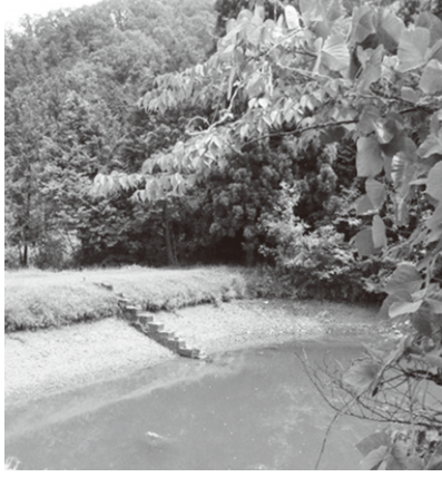
取水施設の更新を行う袋池
