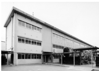
平成26年度空調設備設置予定の昭和小学校
