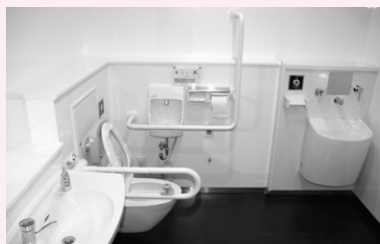
多目的トイレ
