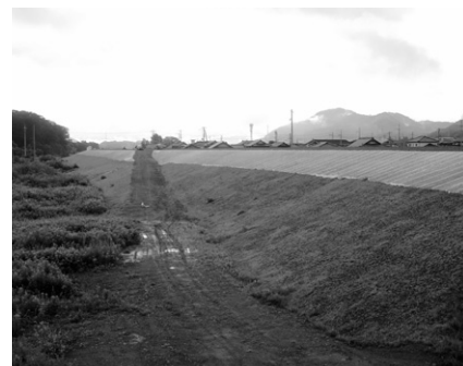
▲改修が進む由良川堤防（戸田）
